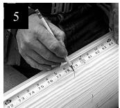
Mida de la nueva medida de la parte superior del eje a la longitud apropiada y haga una serie de marcas alrededor del eje de la columna.
