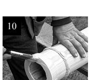
Pinte la parte superior del eje con una capa preparatoria exterior base de aceite o acrílica y látex, y dos capas de pintura.
