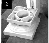
Una manera fácil de lograrlo es apilar la tapa y la base sobre la plataforma, y después medir desde la parte superior de la tapa a la viga.
