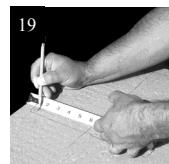
Marque el lugar de los pernos de ancla en las esquinas del trazado— $\frac{1}{2}$ " de cualquier lado. Marque para dos pernos situado diagonalmente en esquinas opuestas.
