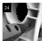
Utilizando los agujeros guía, una la base con dos tornillos resistentes a la corrosión de  $2\frac{1}{2}$ ". Quite los clavos, perfore los agujeros guía e instale dos tornillos adicionales.
