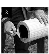
Usando una capa de pintura para azotea, sin fibras, de sequedad sólida, de tipo asfalto, pinte el interior del eje de arriba para abajo, hasta donde usted pueda alcanzar.
