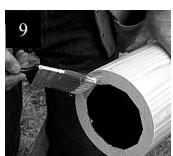
Pinte el extremo inferior del eje con una capa preparatoria exterior base de aceite o acrílica y látex, y dos capas de pintura.
