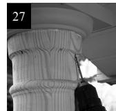
Taladre cuatro agujeros guía abocardados a través del borde de la porción más ancha de la parte superior del eje en la tapa.
