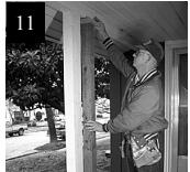
Usando un gato y un poste, levante la viga con el gato lo suficiente como para quitar el poste existente, no más que  $\frac{1}{4}$ ".
