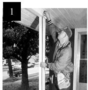
Mida la distancia total de la parte inferior de la viga a la plataforma, menos la altura combinada de la tapa y de la base.
