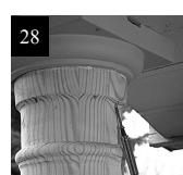
Drive four tornillos de tabla roca resistentes a la corrosión en un ángulo a través de la porción más ancha de la parte superior del eje en la tapa.
