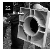
Centre la base en la parte inferior del eje. Utilice un par de clavos para mantenerlo en lugar temporalmente.
