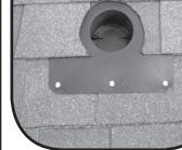
3. Deux options sont possibles, brancher maintenant le conduit de l'aérateur sur l'adaptateur en utilisant un collier de serrage ou, après l'installation, brancher le conduit, de l'intérieur des combles.
