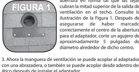
3. Ahora la manguera de ventilación se puede acoplar al adaptador con una abrazadera, o también se puede acoplar desde adentro del ático después de instalar el adaptador.
