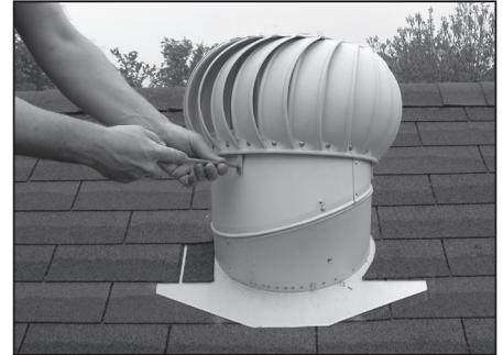
5. Introduire une vis dans le trou du support et dans le nouveau trou de l'embase et serrer.
