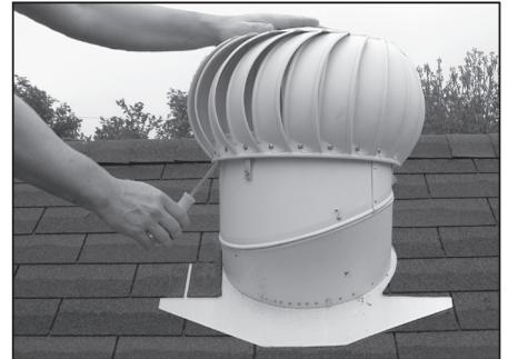
8. La turbine a pu bouger légèrement au cours du transport. Si nécessaire, procéder à des ajustements mineurs en soulevant légèrement la turbine à partir de son extrémité inférieure afin d'éliminer toute oscillation éventuelle.
