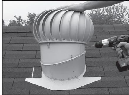
3. Abaisser la pièce avec précaution jusqu'à ce que les supports intérieurs de la tête de la turbine entrent en contact avec le bord supérieur de l'embase existante. **ATTENTION : NE PAS ESSAYER DE MARIER LES TROUS EXISTANTS DE L'EMBASE AVEC CEUX DES SUPPORTS. IL EST NÉCESSAIRE DE PERCER TROIS NOUVEAUX TROUS.**
